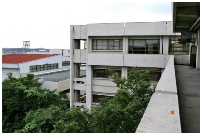
2005 年頃の 5 号館 (永井孝撮影)
