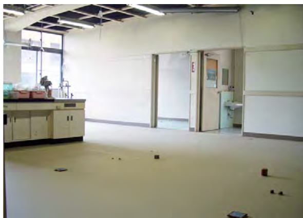
床工事が完了した 9 号館の研究室
