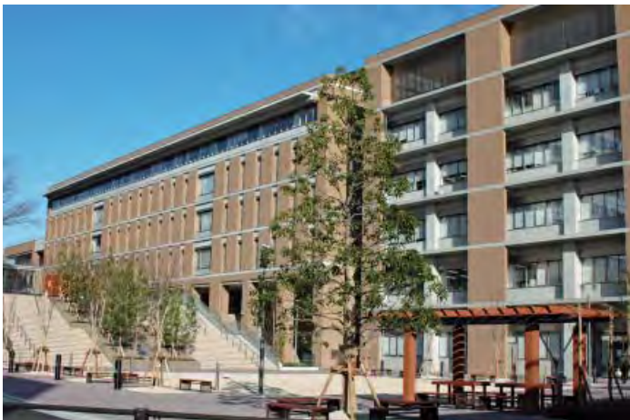
左側が共通講義棟北館，右側が研究実験棟 I
