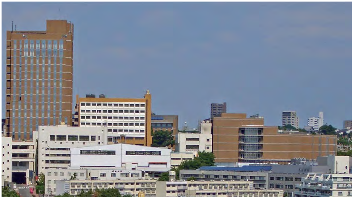
2007 年（平成 19 年）6 月，5 号館跡地に研究実験棟 I が建つ。 まだ 5 号館南側は残っている．
