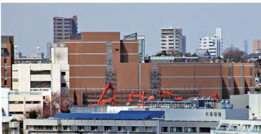
2006 年（平成 18 年）3 月，5 号館北側部分が解体され，1 号館跡地に建てられた共通講義棟北館が姿を現す。
