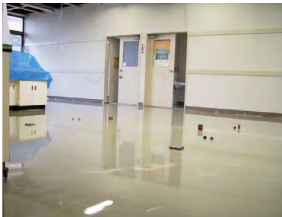
床を剥がした後、セメントを流し込んだ
