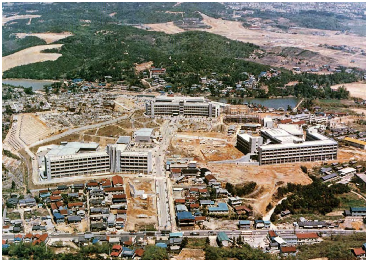
昭和 43 年（1968 年）の天白キャンパス 5 号館は建設中！
