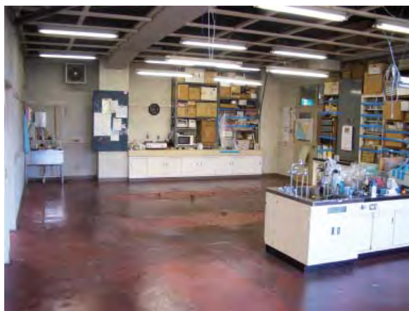
床工事前の 9 号館の研究室（2）
