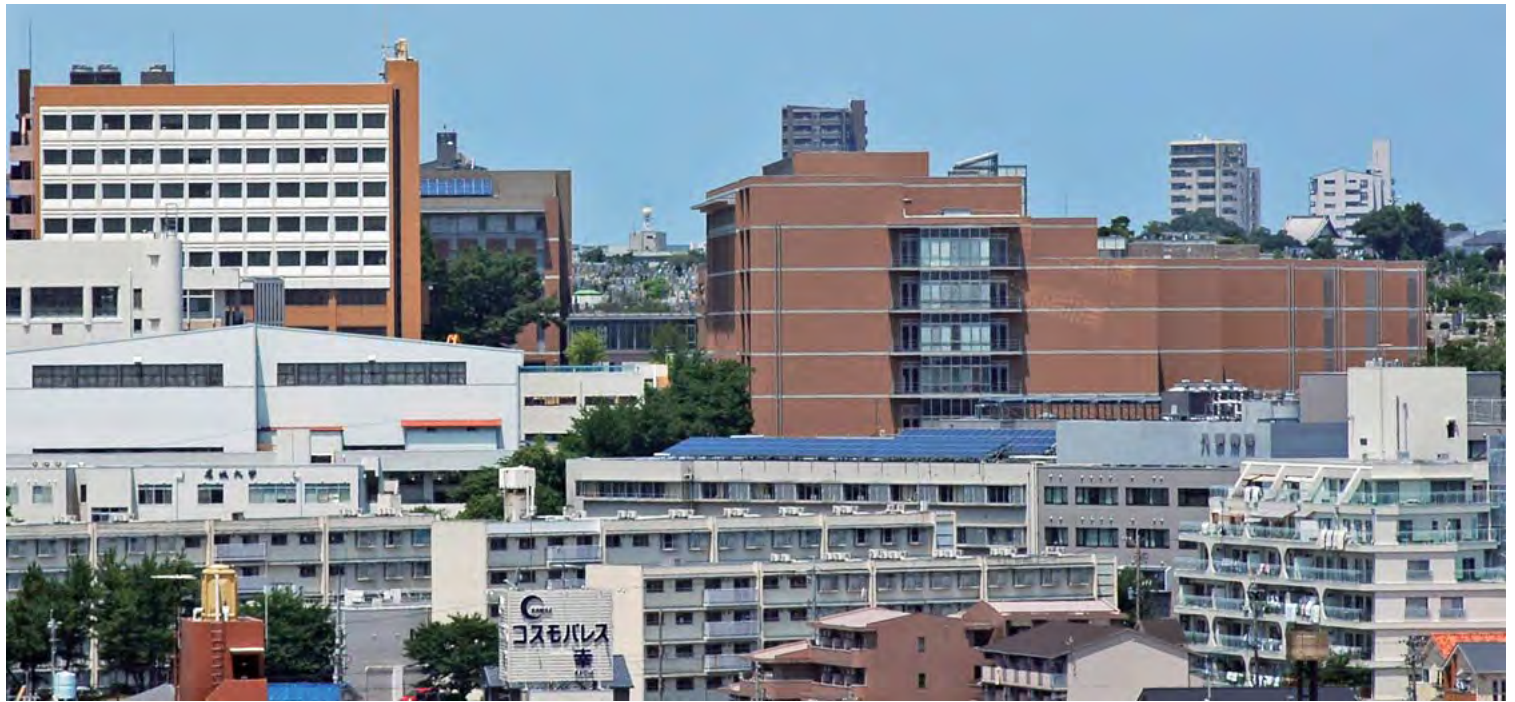
2008 年（平成 20 年）夏，ついに 5 号館は完全に消滅してしまいました．左側には 9 号館がありますが，クラブハウス（8 号館）の陰になってほとんど見えません．
