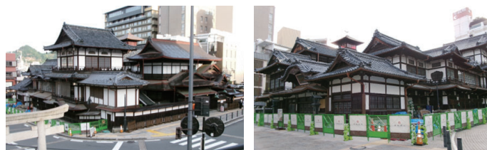
国の重要文化財である道後温泉本館が5年の保存修理工事を経て7月に全館再開となりました。
